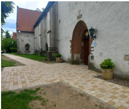
Neue Pflasterung des Zuganges der St. Marienkirche Isernhagen © Frau Dr. Grunewaldt-Stöcker
