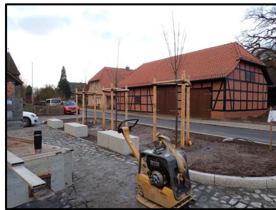
© Planungsbüro Ackermann - der Lindenbrink in Otze während der Bauphase
